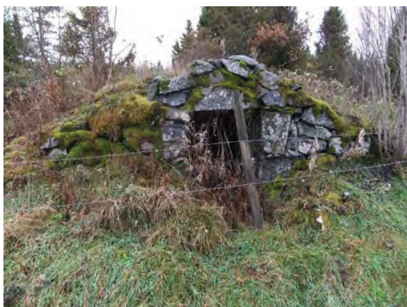
Figur 158. Jordkällaren som tillhörde torpet Nydala, känt sedan 1700-talet. Ingången är slagen i ett valv. Foto mot syd.
